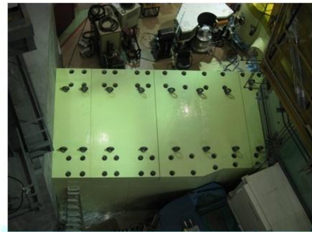
조립식 차폐체 설치 08.10. 5
